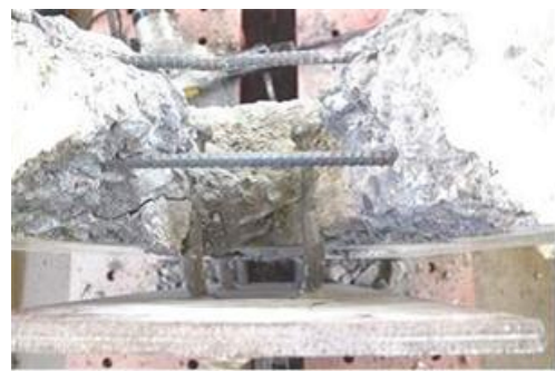
写真-2 NR3-T15 の上段スタッド周り
