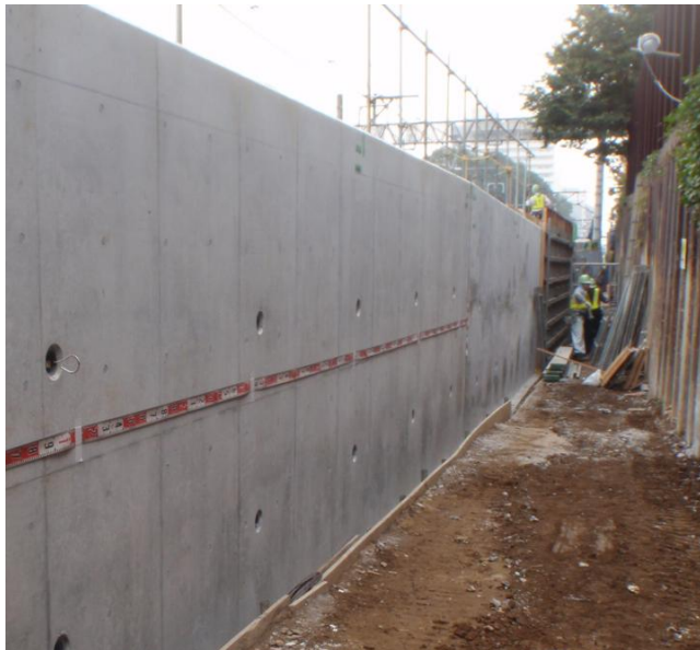
写真 1-1 ( 施工中現場写真 )
