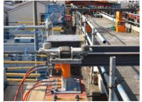
（写真2 ジャッキ(ローラー設置)）
