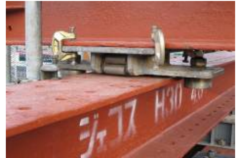
（写真3 EG下部ローラー設置）
