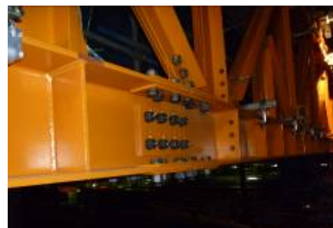
(写真1 エレクションガータ添接板)
