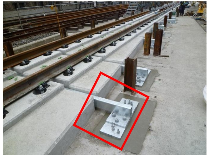
図—4 高架橋連結工
