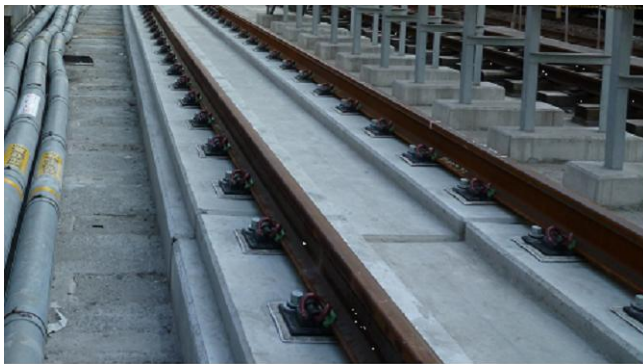
図 - 3 コンクリート直結軌道
