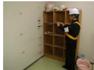
写真-3 埋設ケーブル探索機による探査
