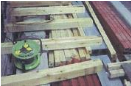
写真－2 使用材料仮置状況
