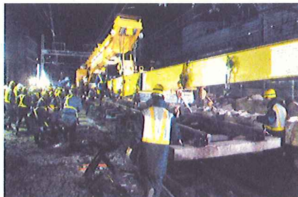
写真-2 分岐器撤去
