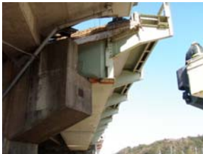
写真ー1 桁移動状況
