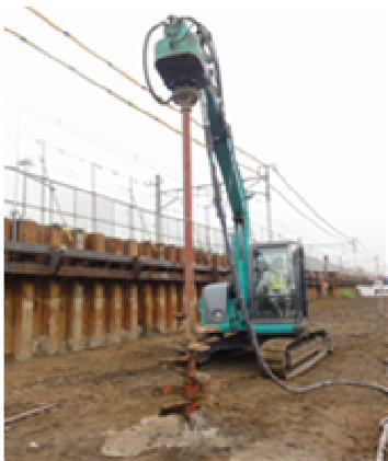
写真-1 試験施工状況
