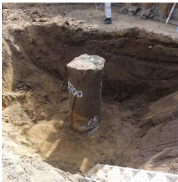
写真-2 改良体の形状確認
