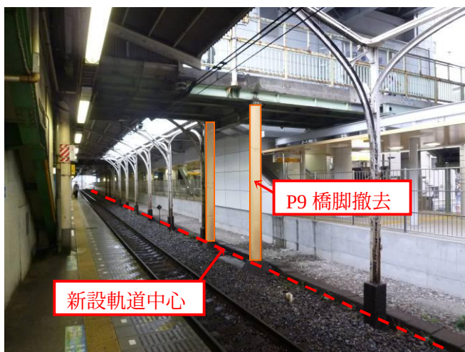
写真-2. 紅葉坂こ線人道橋側面(起点方より)
