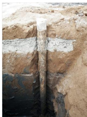
写真 1 杭状地盤改良体
