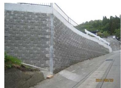
図-3 地震後のブロック式補強土壁 (2011年6月撮影)
