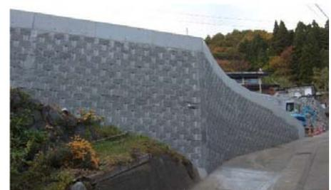
図-2 完成後のブロック式補強土壁
