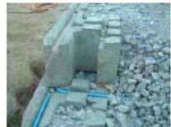
図 - 6 ブロック結合の凹凸状況
