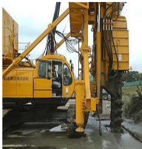
写真 - 1 施工写真
