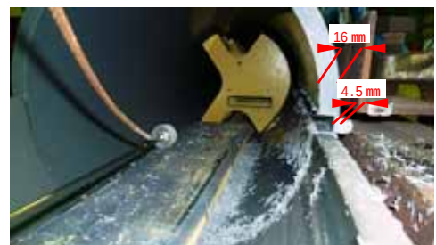
写真-2 管路切削状況(到達側より)
