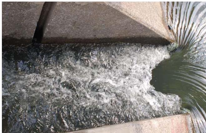
写真5 洪水調節堰スリット部流入部付近の通常時流況
