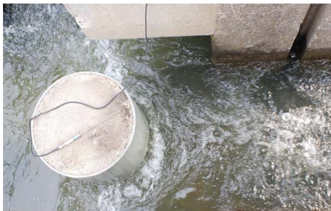
写真4 洪水調節堰スリット部円柱杭付近の通常時流況
