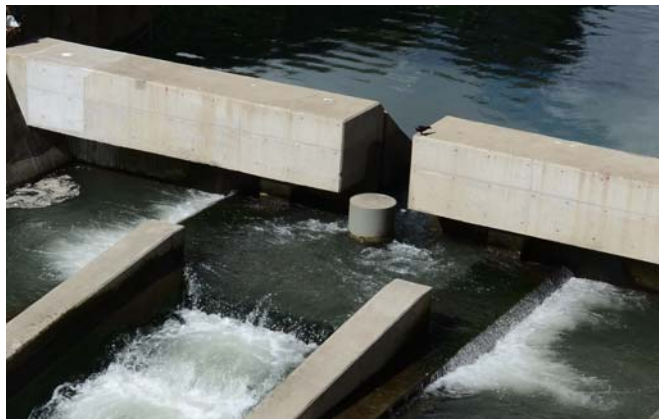
写真6 洪水調節堰スリット下流側プールの様子
