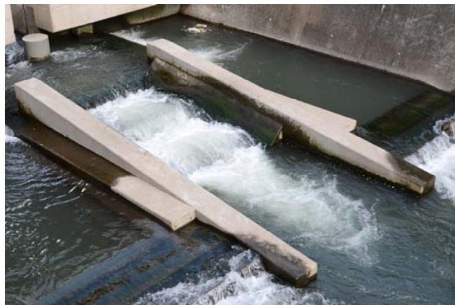
写真7 整備された台形断面魚道(通常時)
