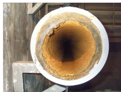
写真 2 送水管内部状況
