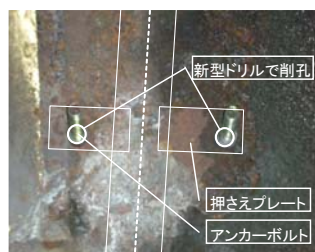
図-4 連続削孔による 支保工固定方法
