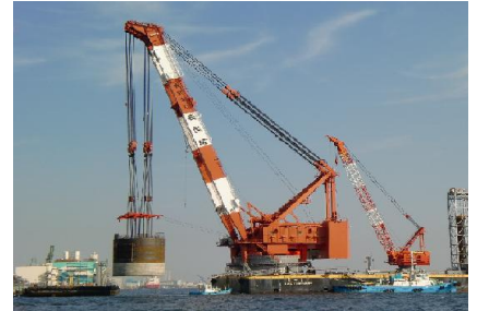
図-4 ケーソン据付状況
