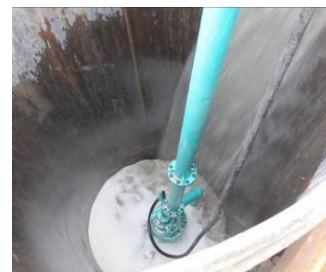
図-6 スライムポンプ使用状況
