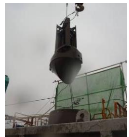
図-7 鉄筋撤去状況
