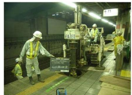
写真-2 EAZET 杭施工状況
