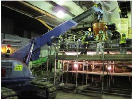
写真.1 実物大試験体への打設
