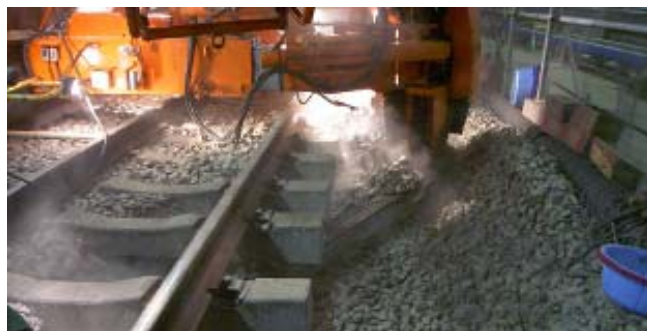
図3 軌陸式道床機による掘削
