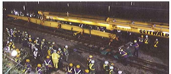
写真-1 分岐器挿入写真
