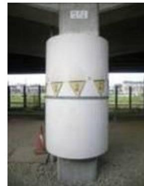
写真 1 柱継ぎ足し部鋼管巻き
