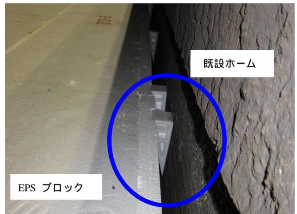
写真-1 くさび設置状況
