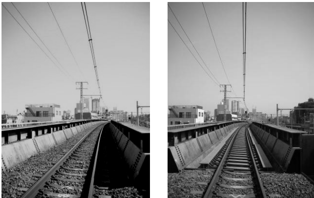
施工前 写真-1 施工前後写真(終点方→起点方)
