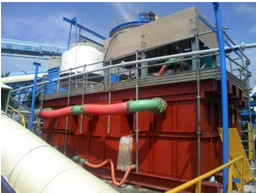
写真-1 設置状況
