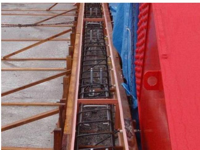
写真-2 地覆の鉄筋および型枠の組立状況
