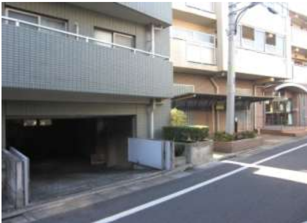
図-4 浸水しにくい地形にある半地下構造空間
