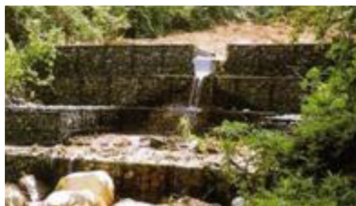
写真-1 鋼製枠砂防堰堤
