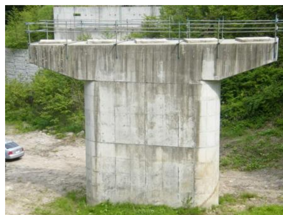
写真-1 新田代橋の RC 橋脚
