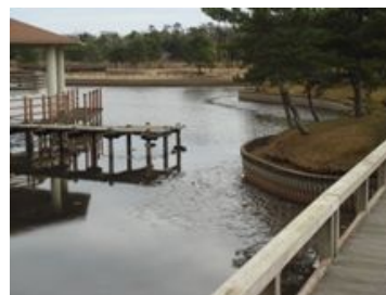
図1 水抜き(改善工事)中の蓮沼
