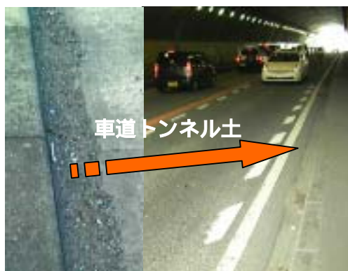
写真1 隧道内に残積する車道トンネル土
