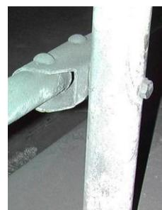
写真-2 ガードレールに付着した車両排気煤煙
