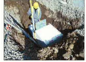
図-5 埋設した発砲スチロール
