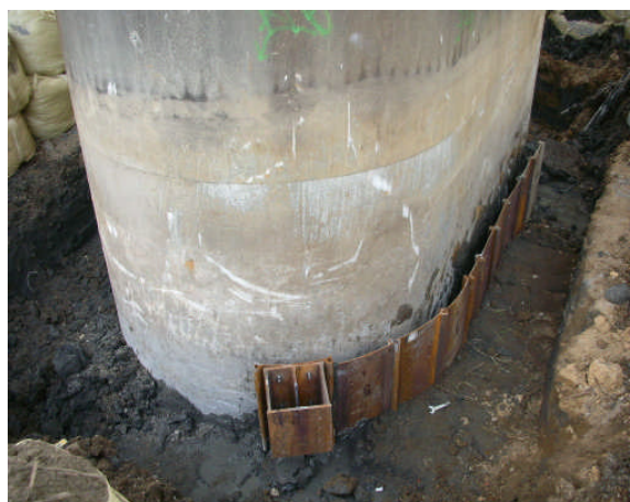
写真－2 直線型鋼矢板工
