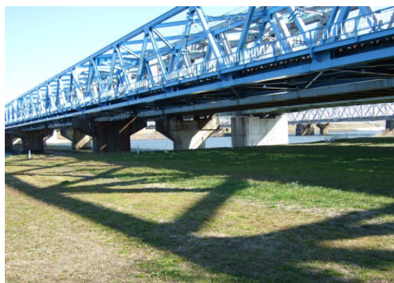
写真－1 橋脚耐震補強例
