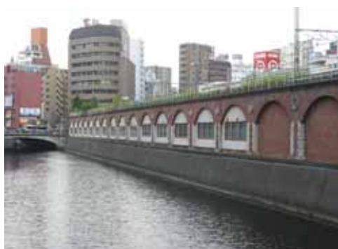
写真 1 万世橋高架橋の全景
