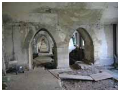
写真 2 北側高架下(連絡通路部)
