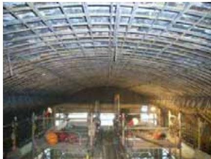
写真3 上床版の配筋
