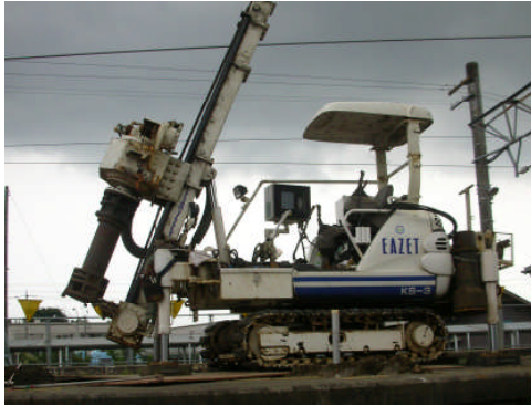
写真 1 杭打ち機全景
