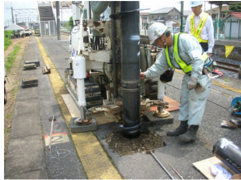
写真 2 杭打設状況
