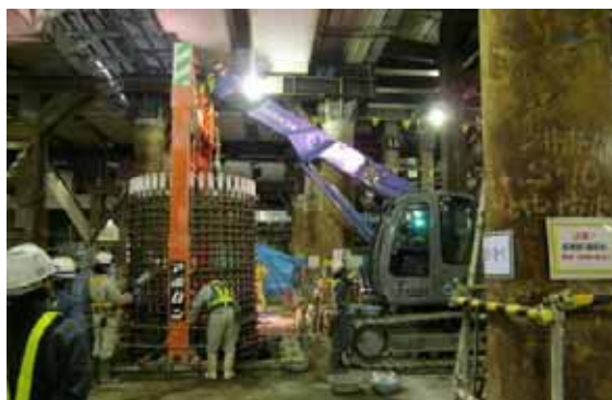
写真 低空頭多滑車を用いた鉄筋籠建込みの様子
