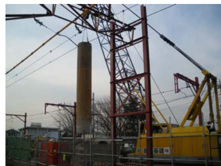
写真2 場所打ち杭施工
