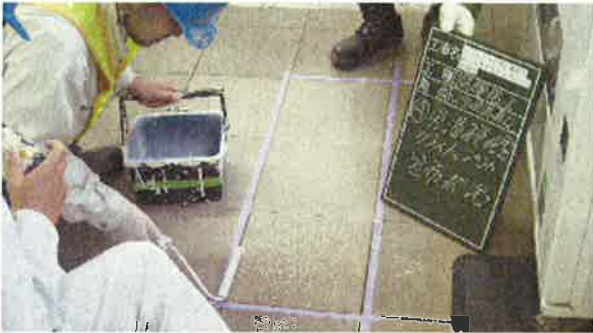
写真-3 現地試験施工状況
