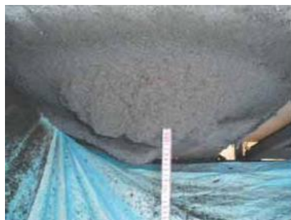
写真-1 天井面吹き付け厚
