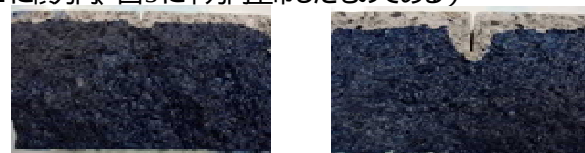
写真-1 ひび割れ深さ 5mm 写真-2 ひび割れ深さ 15mm
