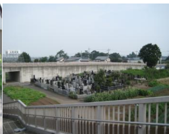
写真-2 橋隣接タイプ
