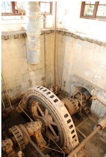
写真3 放水口発電所建屋内部に設置された発電機
