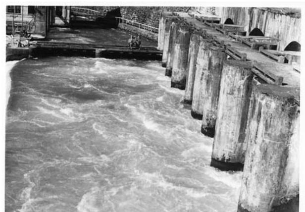
写真6 出水時における八百津発電所放水口
