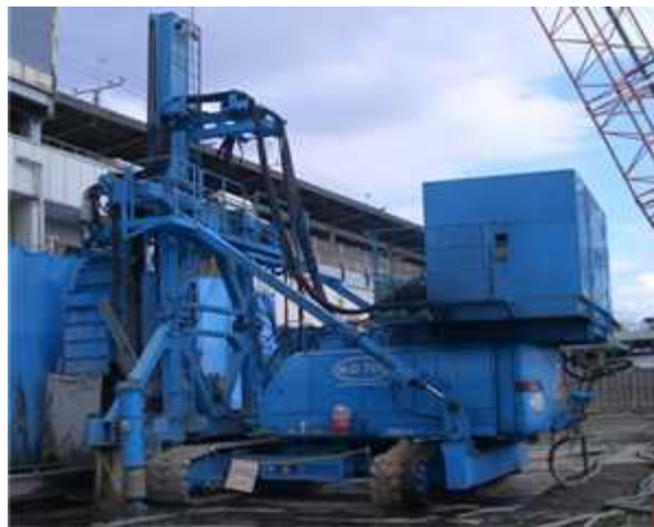
図 1 TRD 工法施工機
