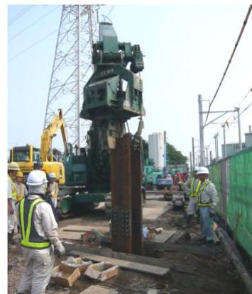
写真-2 H 形鋼挿入状況
