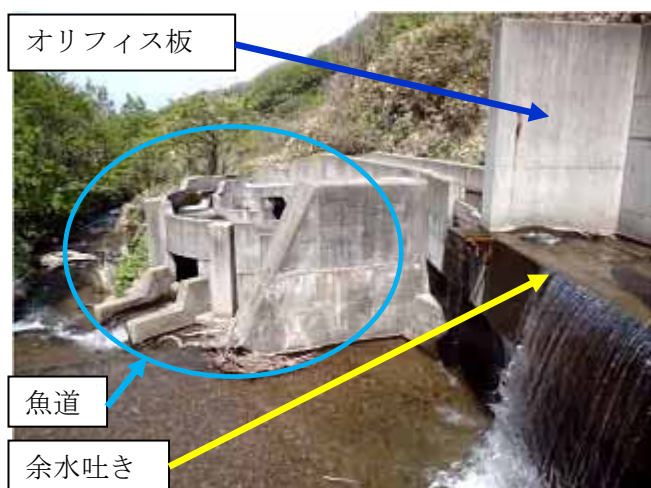
(a) 上流側から見た状況
