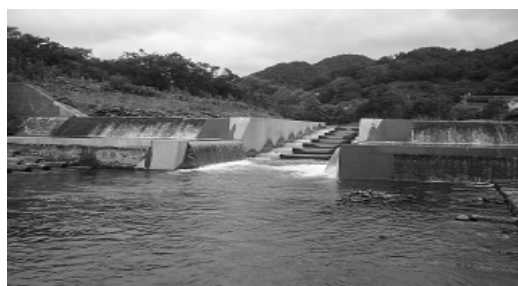
写真 1 引き込み型魚道の設置事例
