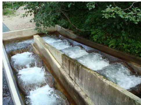
写真3 S河川に設置された台形断面魚道 (i=1/8, b=2.5m, m=1, S=25cm, h=50cm, Q=0.4 m<sup>3</sup>/s)
